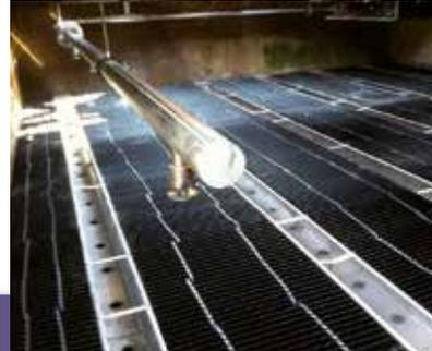
Remplacement de la distribution d'eau en tubes par des canaux à ciel ouvert pour faciliter la maintenance
