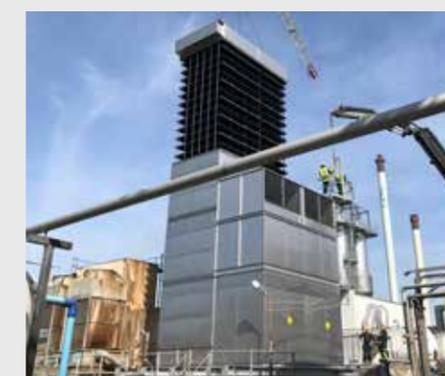
Le système X-Tract a été spécialement conçu pour simplifier les opérations d'installation et de maintenance. En un seul levage, la surface d'échange, la distribution d'eau et les éliminateurs de gouttes sont intégralement retirés, ce qui permet un nettoyage complet des internes et de l'enveloppe au sol.
