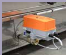
Vanne motorisée de vidange
