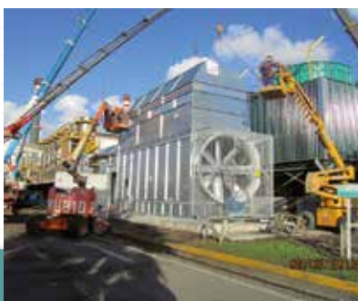
Coordination de chantier
