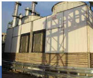
Création d'accès pour la maintenance
