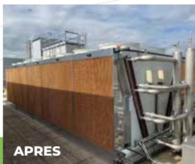
Amélioration des performances des Drys et Groupes Froids par Adiabatisation sécurisée
