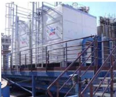
Transformation en circuit fermé
