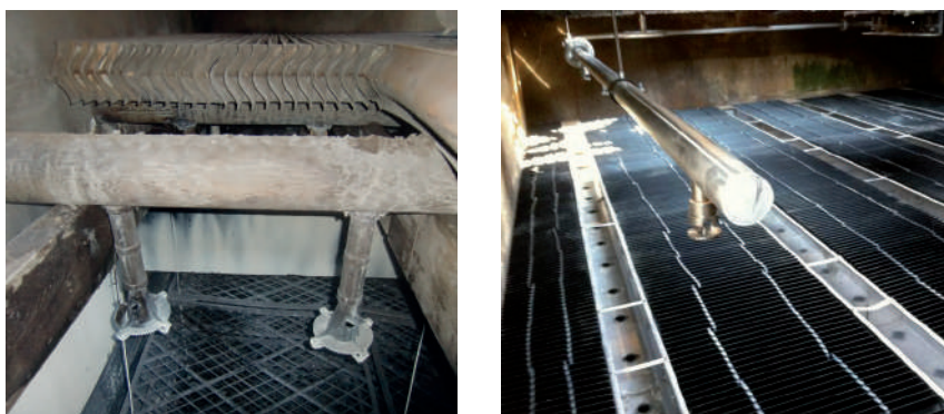
Remplacement de la distribution d'eau en tubes par des canaux à ciel ouvert pour faciliter la maintenance
