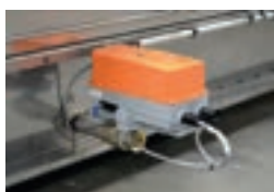
Vanne motorisée de vidange
