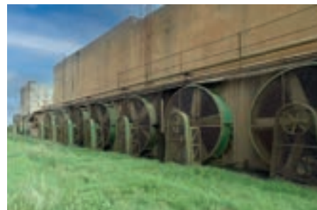
Rénovation tour béton
